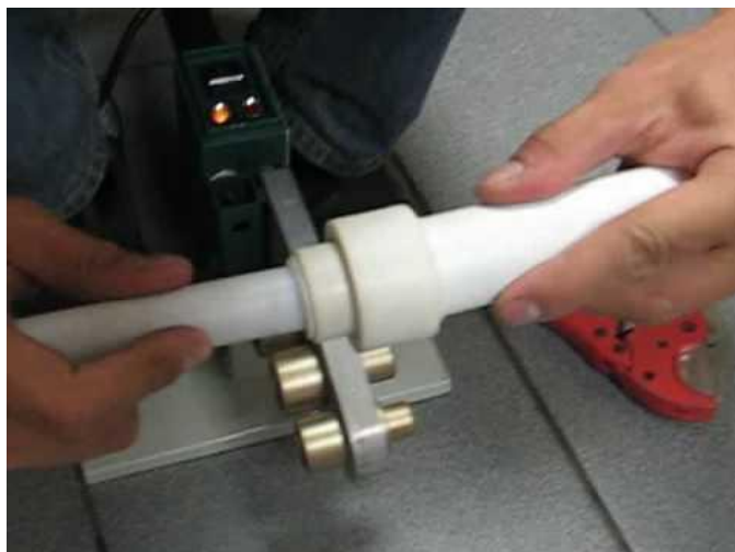
Рис. 3. З'єднання за допомогою нагрівання
